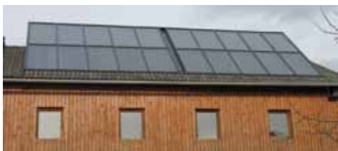
„6-7 Kipper Hackschnittel musste ich im Sommer für die Warmwasserbereitung einbringen, das hat sich ab diesem Jahr fast zu 100% minimiert!“
